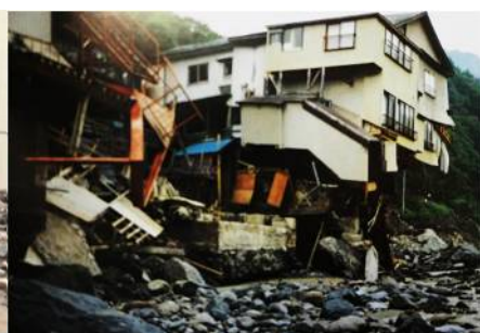
平成7年小谷村豪雨災害の様子
